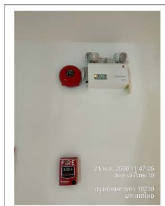
เครื่องแจ้งเหตุฉุกเฉินและกริ่งสัญญาณเตือนภัย
