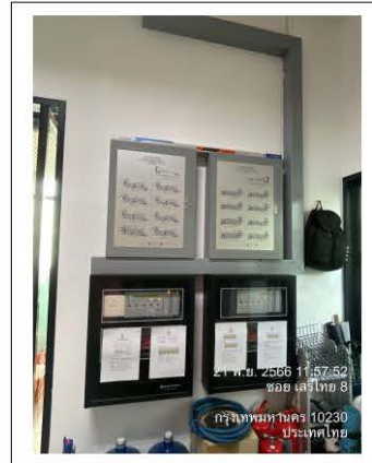
แผงควบคุม Fire Alarm
