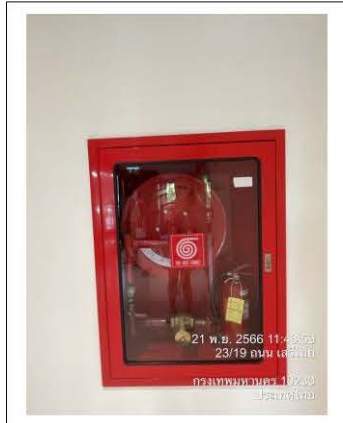
ตู้เก็บสายฉีดน้ำดับเพลิง
